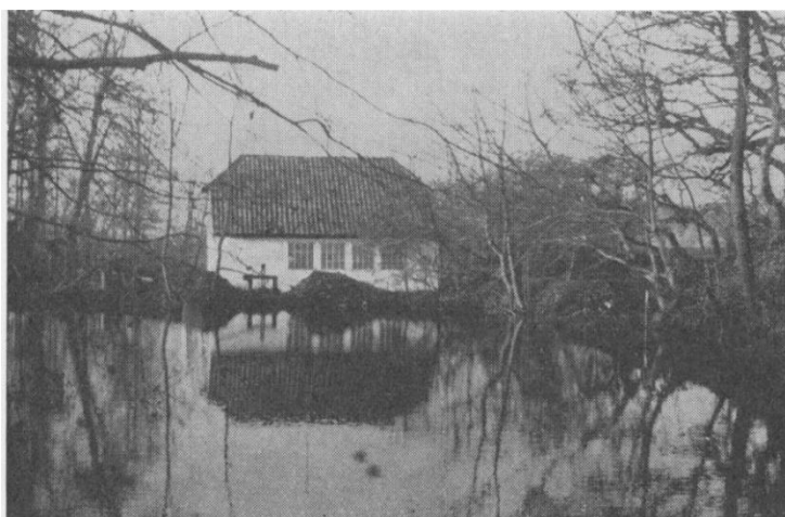
6. Fotografi fra ca. 1890, kort før jernbandedæmningen blev anlagt. Mølledammen ligger nord for huset, der var i to etager. Foran møllehuset ses stigbordet, som lukker vand ind i vandstuen, hvorfra det løb ned over det 4-5 meter store møllehjul inde i huset. Bag de store vinduer stod kværnene, mens undermøllen har indeholdt gearværk og grubeværk (grynmølle), der var farligt at have på kværnloftet, fordi stenen kunne springe.
